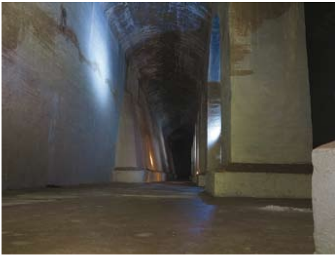
Fig.3 - Profilo del Torrione del Monte (foto: M. Betti). Fig. 3 - Monte tower profile (photo: M. Betti).
