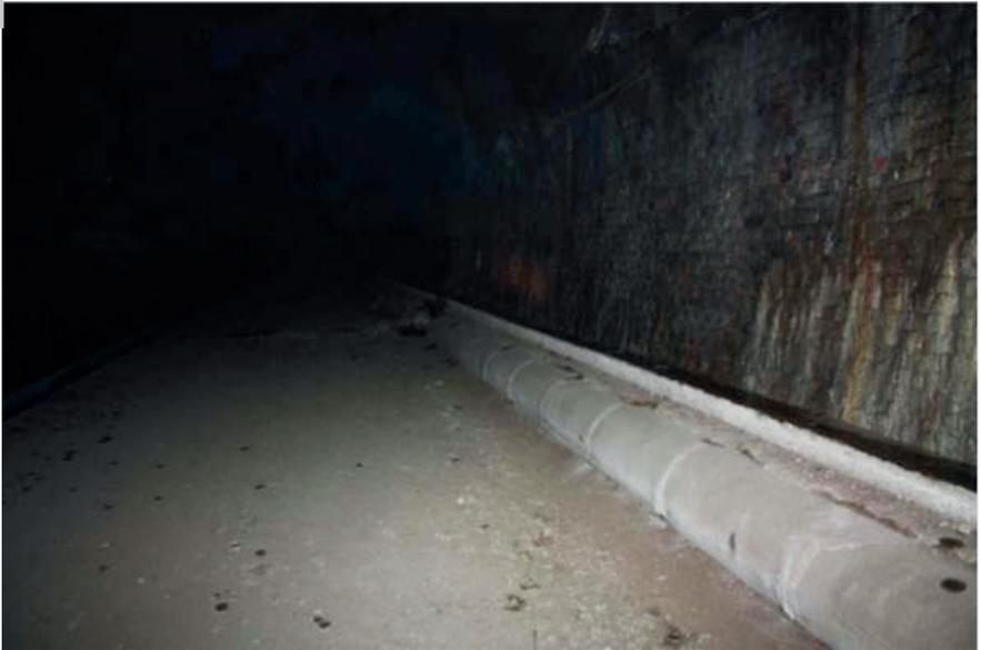
Trasanni, non ha subito bonifiche. La galleria è caratterizzata da una stabilità alquanto precaria e suscettibile di crolli improvvisi; inoltre, essendo l'uscita ostruita, altimetricamente depressa rispetto l'imbocco, sussiste il rischio di intossicazione da anidride carbonica prodotta dalle traversine in putrefazione, unitamente all'idrogeno solforato emesso da una sorgente sulfurea sita in una condotta laterale di areazione il cui imbocco è occluso esternamente. In
