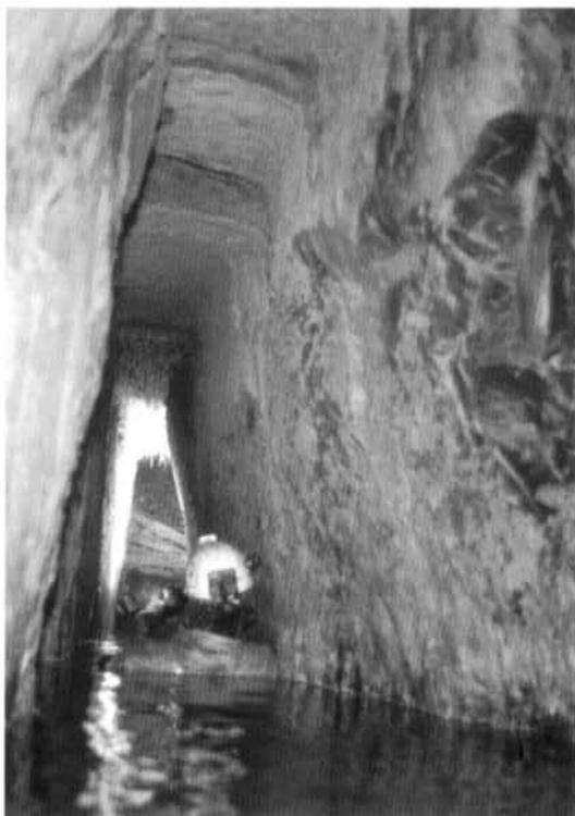
La formazione presenta diaclasi in evidenza negli strati arenacei e una fratturazione diffusa nei litotipi marnosi soggetti, come già evidenziato, a fenomeni di degradazione fisica che hanno originato più a valle, in prossimità del pozzo di accesso, depositi di fango dello spessore di circa 30 – 40 cm.
